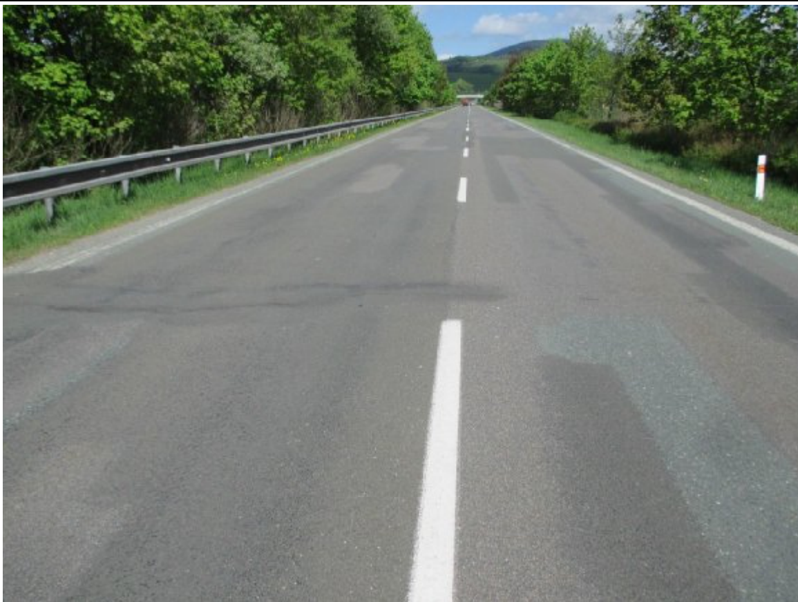
F27, km 7,710+ Vysprávký nátěrové/tryskovou metodou, příčná trhlina.
